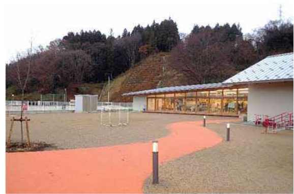
園庭に開いた平屋建ての建物
