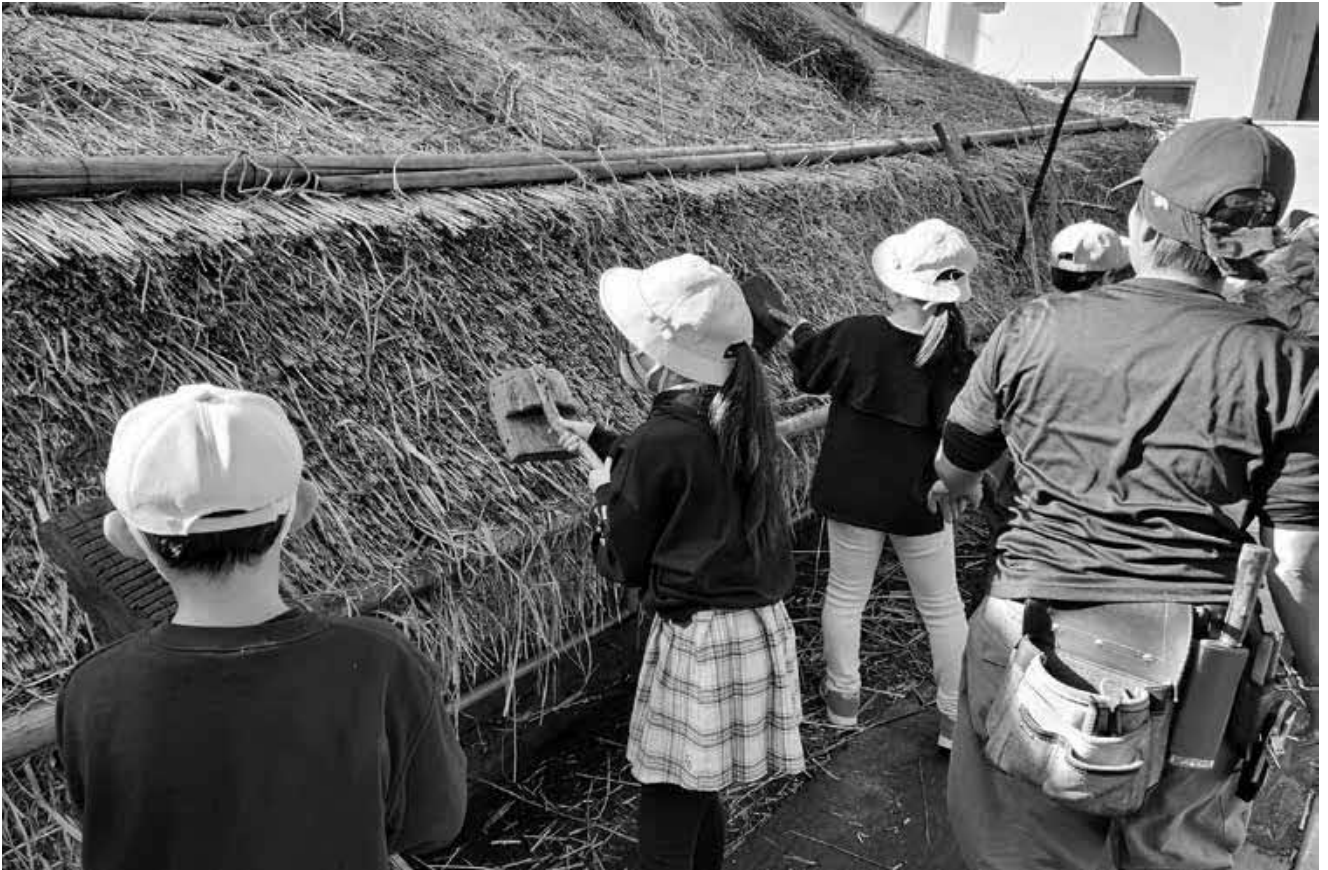
▲屋根の高さまで組まれた足場にのぼり、ガギで茅を整える作業を体験
