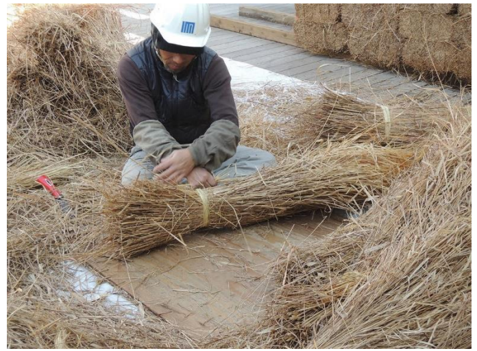
茅拵え（屋根に葺く茅材を束ねる作業）
