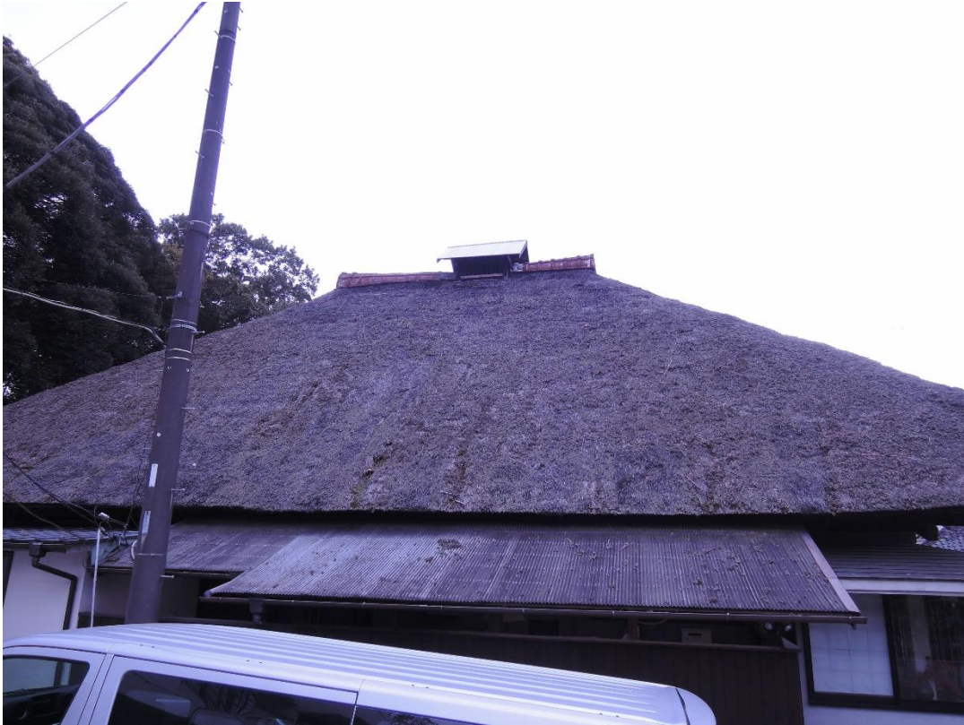
【写真7】小澤家住宅主屋 屋根西側状況（西より）
