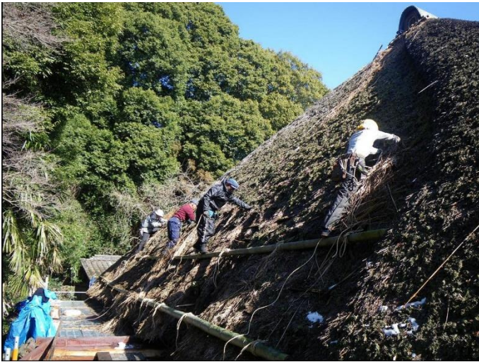
屋根ホゴシ（傷んだ古い茅材を取り除く作業）
