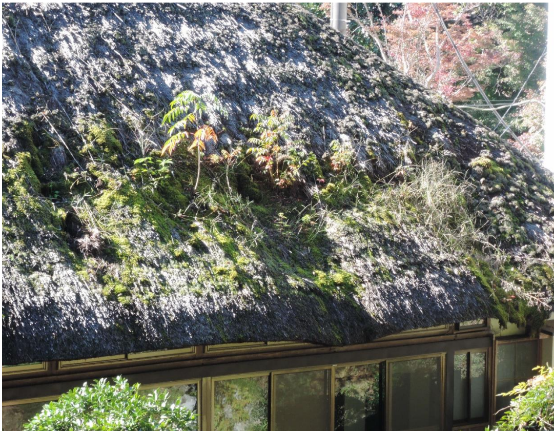
【写真6】小澤家住宅主屋 屋根北側状況（部分）
