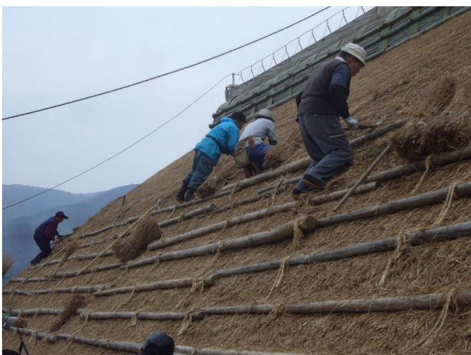
平刈込（屋根の形を整える作業）
