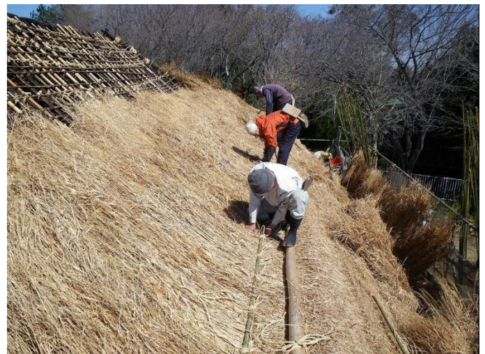
平葺き（軒から棟へ向かって、棟側の茅が軒側の茅の上に重なるように葺く作業）
