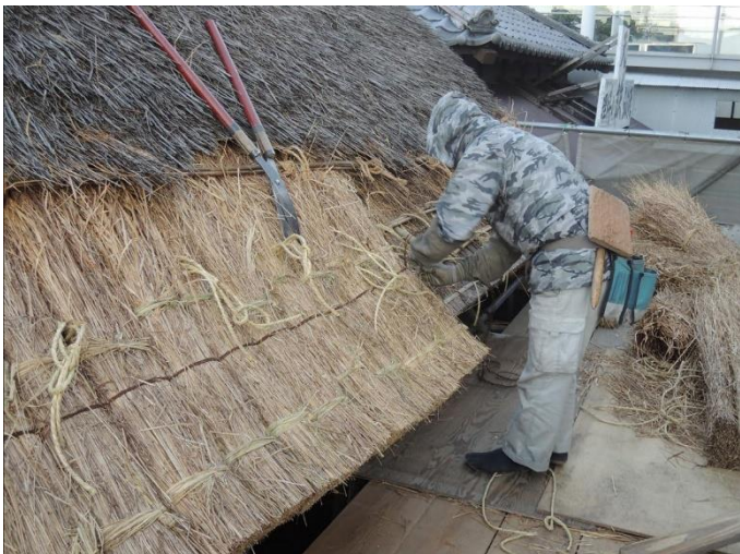
軒付け（束ねた茅を最初に軒に並べる作業）
