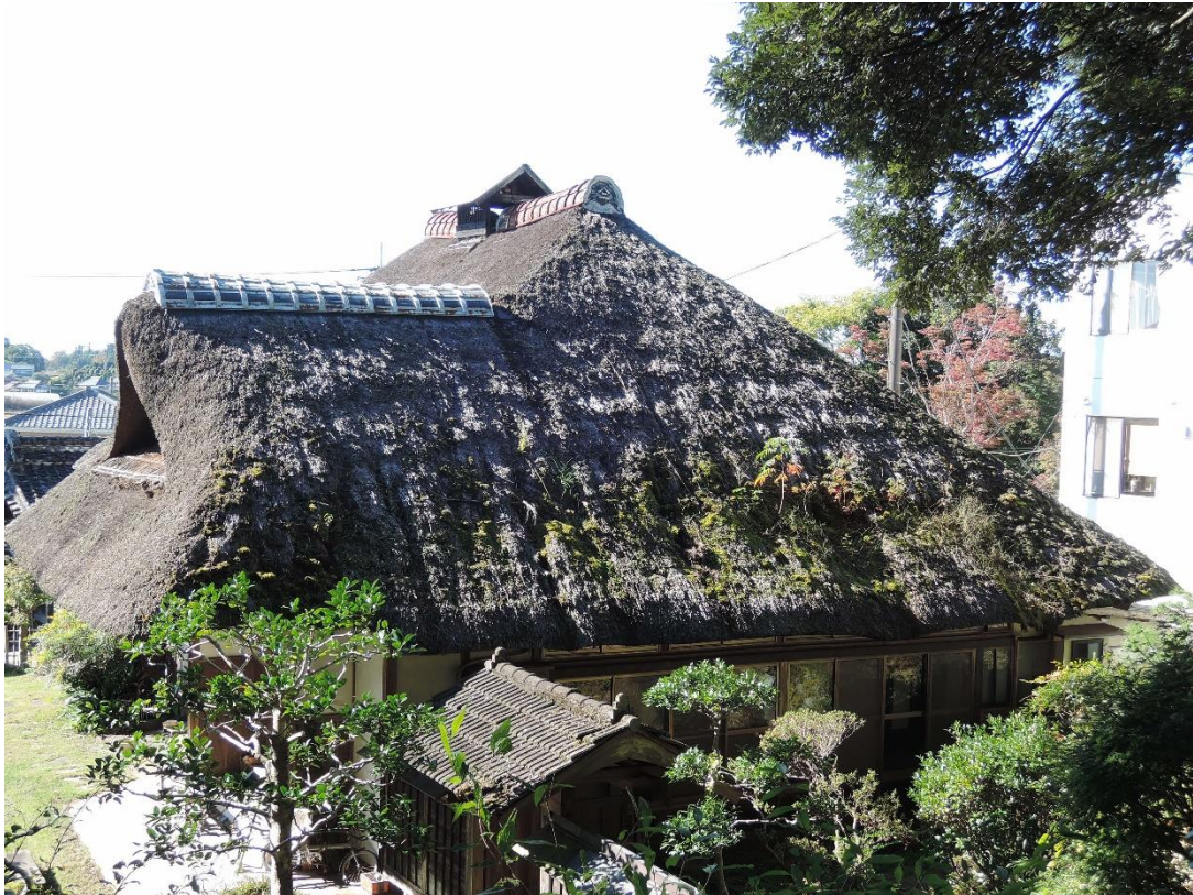
【写真5】小澤家住宅主屋 屋根北側状況（北より）
