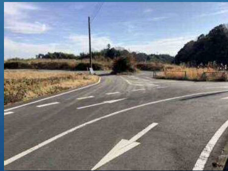
村道1556号線整備
