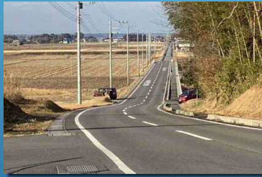
村道105号線整備
