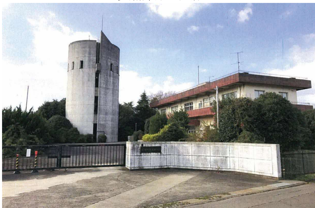
美浦村配水場
