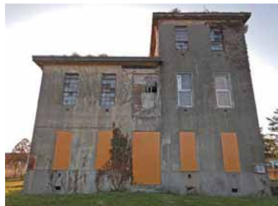
庁舎東面 エレベーター設置跡
