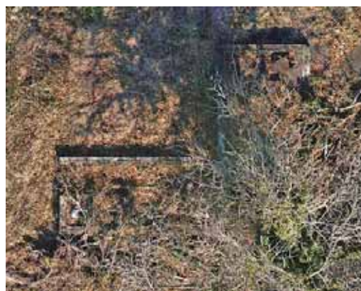
衛兵控所基礎全景
