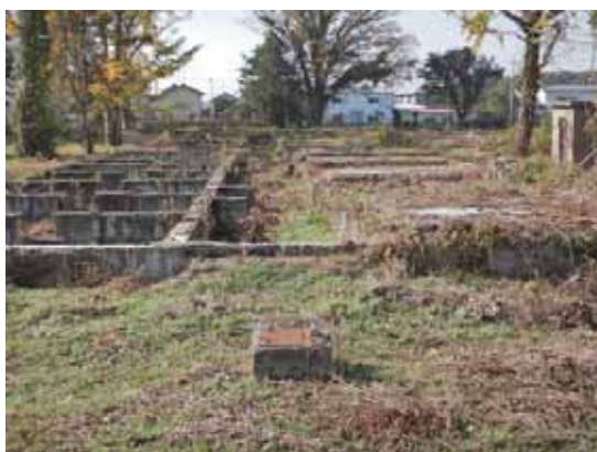
士官宿舎（第1病棟）基礎 東面から
