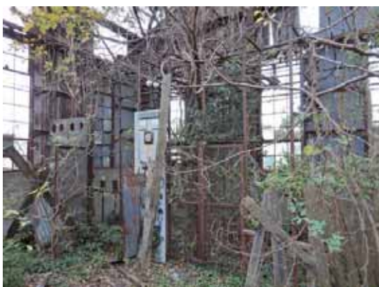
分院時代に変圧施設が設置されていたスペース
