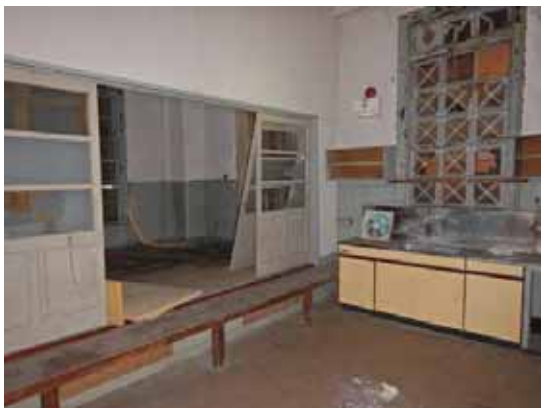
庁舎1階(A14) 北側が和室に改変
