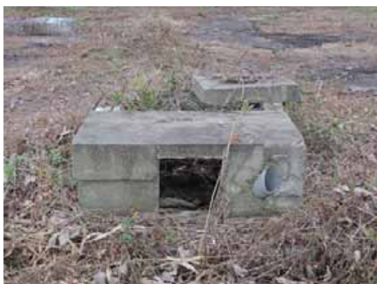
基礎に残るコンクリート製の構造物
