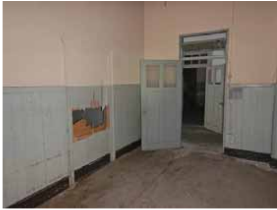
庁舎 2 階 (B17) B16 に通じる扉が外され塞がれている。
