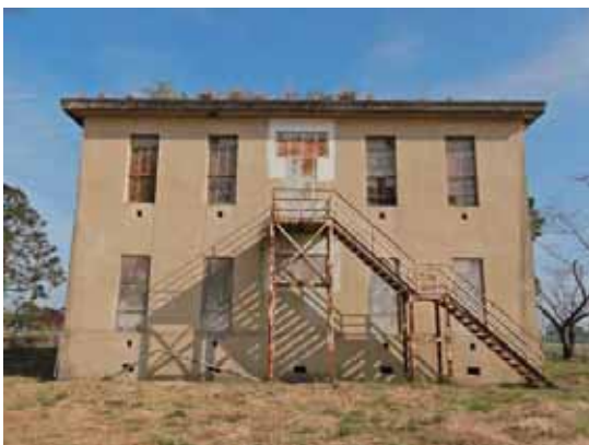
庁舎西面の外階段
