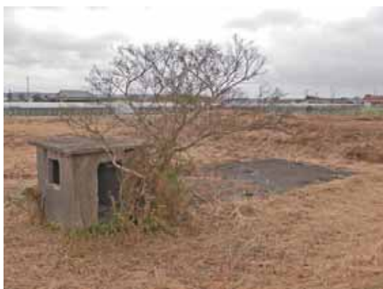
不明建築物 北西側から
