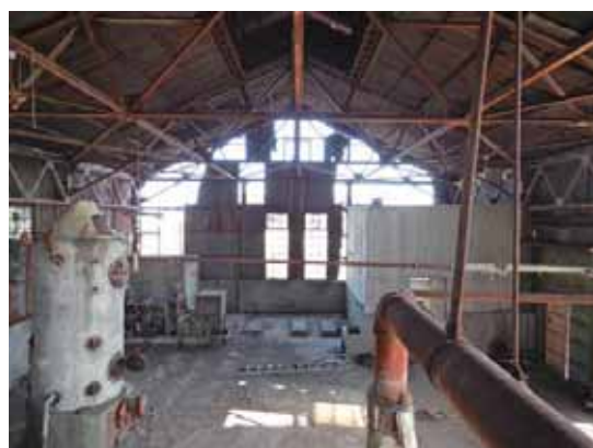
汽缶場内部 西側から
