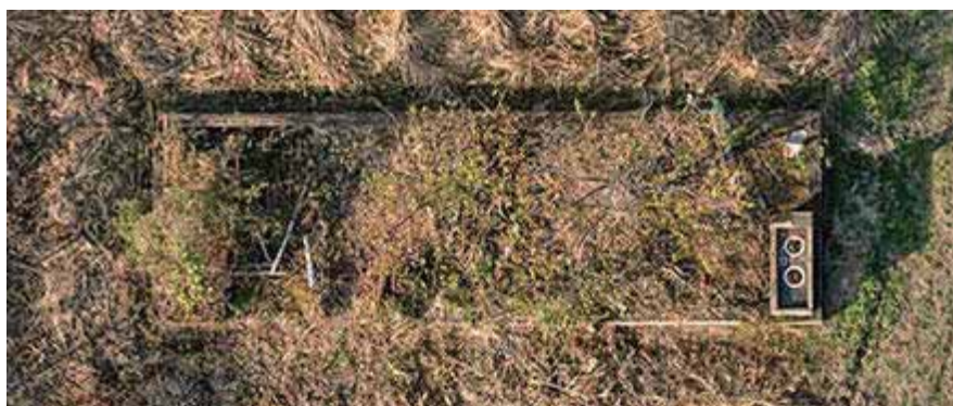
衣服修理所基礎全景
