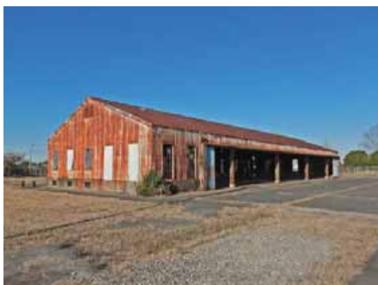
自動車庫 北東側から
