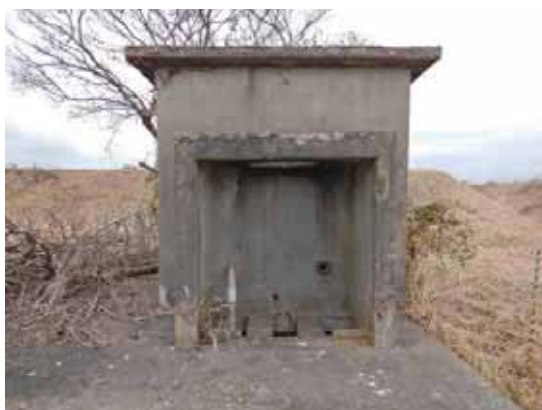
不明建築物 南側から
