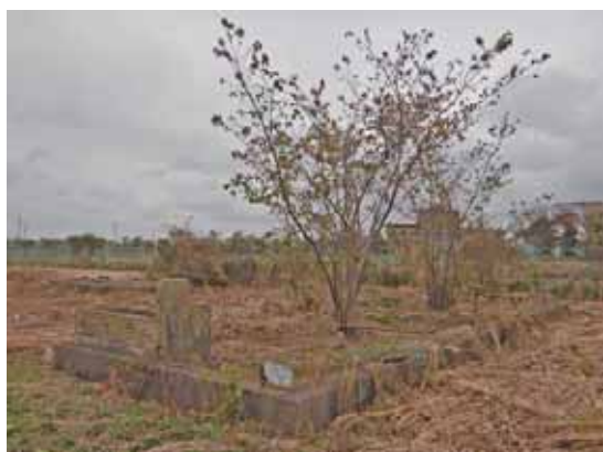
衣服修理所基礎 北東側から
