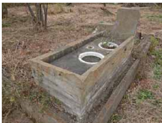
衣服修理所基礎南西端に設置されているコンクリート製構造物 南東側から
