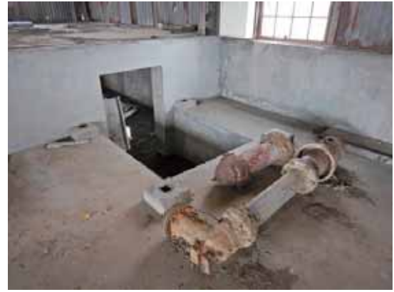
半地下の部屋の入り口 入り口前に消火栓が安置されている。
