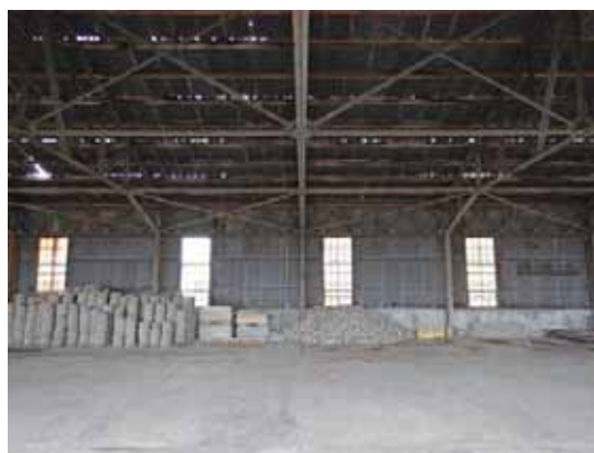
自動車庫内部 東側から
