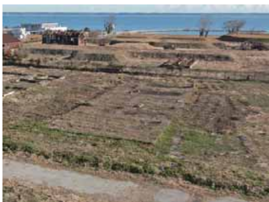
通信講堂基礎 南西側から（庁舎屋上から撮影）
