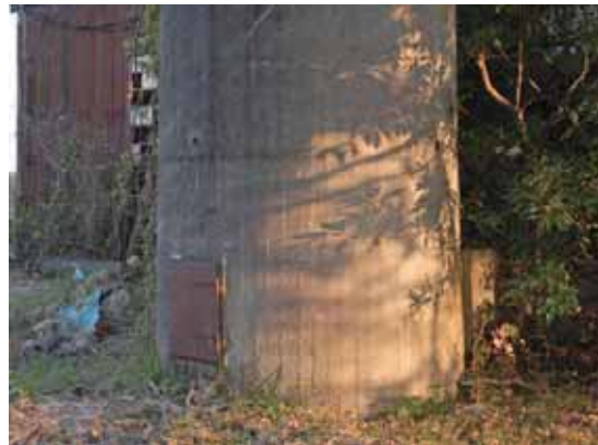
煙突下部 北西側から
