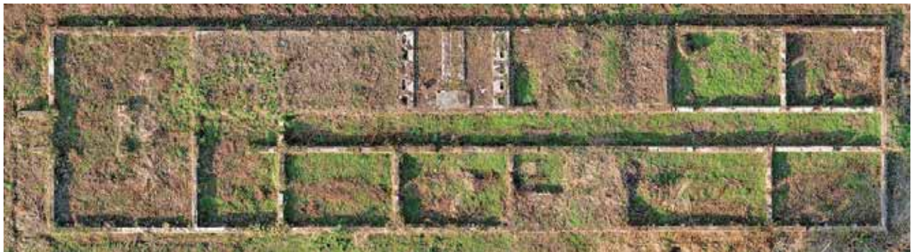
学生舎基礎全景
