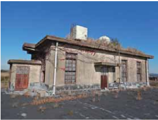
庁舎 3 階塔屋外観 南面から
