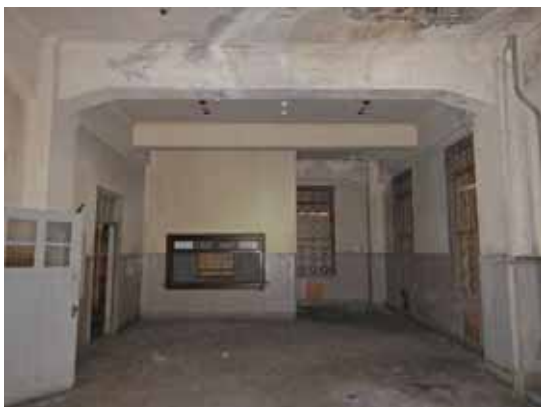
庁舎1階(A20) 西側から
