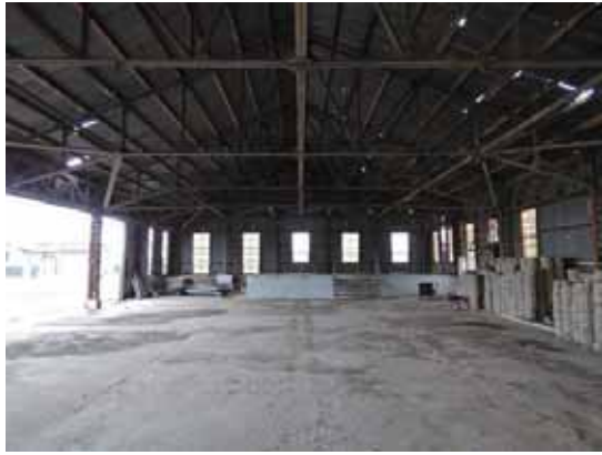
自動車庫内部 北側から
