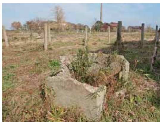
東側コンクリート製構造物
