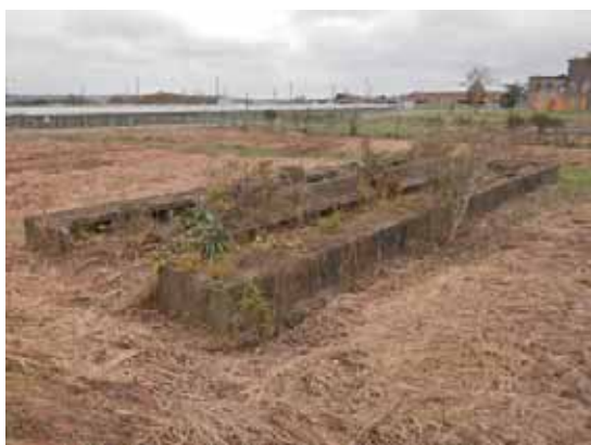
第一兵舎洗面所跡部分 北東側から
