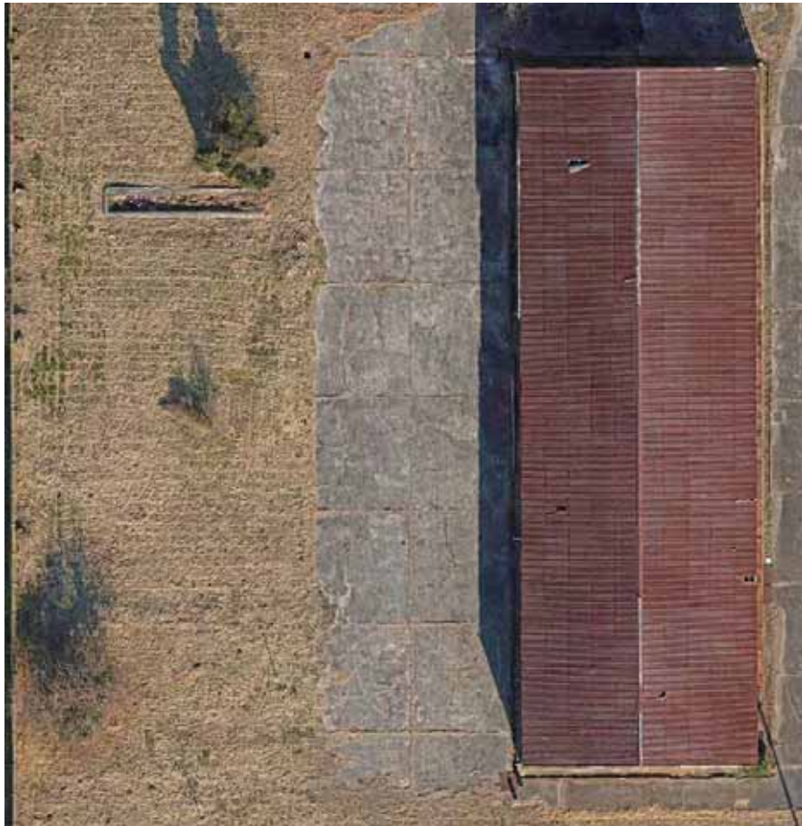
自動車庫俯瞰 西側自動車庫はピット部分のみ基礎が残っている。
