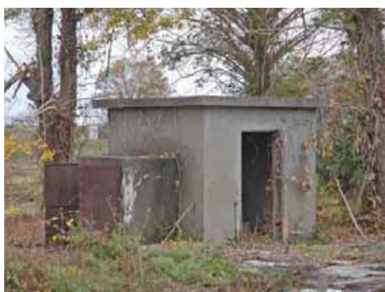
不明建築物 南側から
