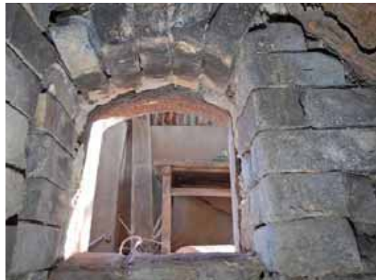
ボイラー側掃除口内部の様子
