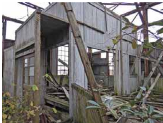
自力発電所内部南東側の宿直室
