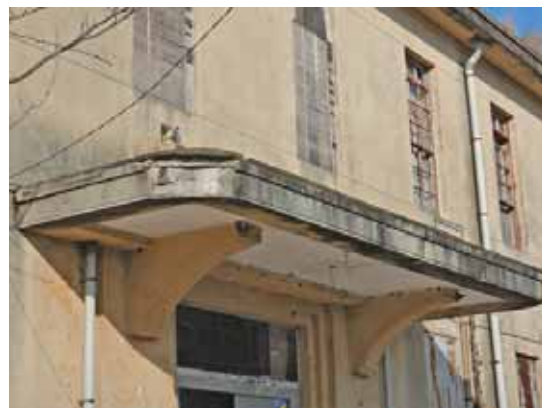
庁舎南面出入口の底部分
