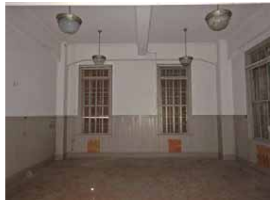
庁舎1階(A12) この部屋のみ照明が残っている
