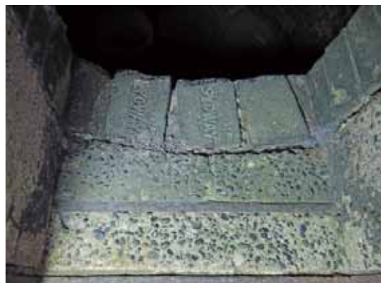
煙突側掃除口 刻印の入った耐火煉瓦
