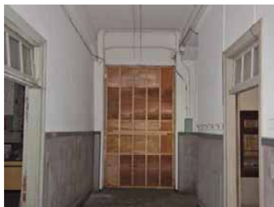
庁舎1階中央廊下 東側壁面
