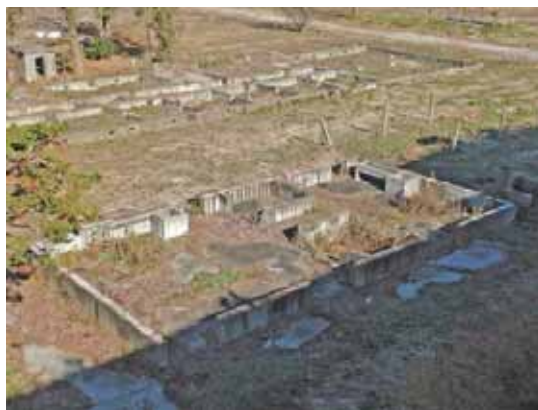
学生舎基礎 庁舎屋上より撮影
