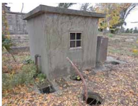
不明建築物 北側から
