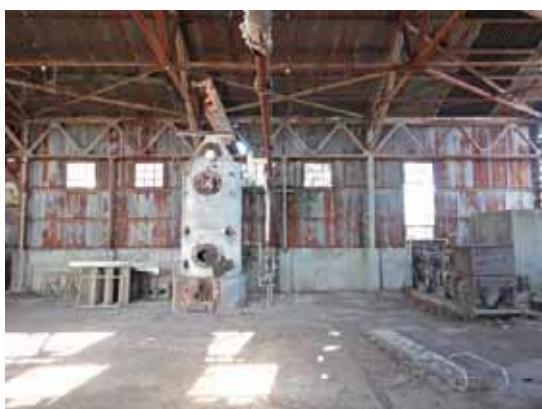
汽缶場内部 南側から
