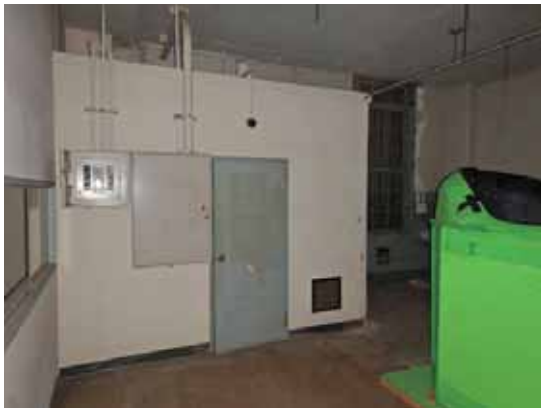
庁舎1階(A3) レントゲン室に改変されている
