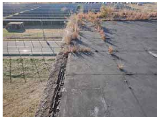
2階屋上縁部分の様子
