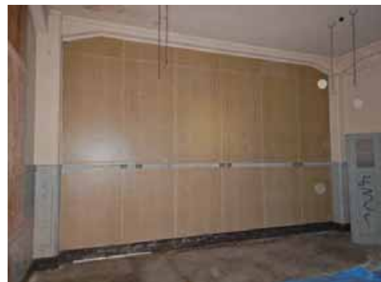
庁舎2階(B20) 西側の合板の壁
