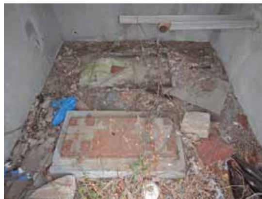
不明建築物内部の様子
