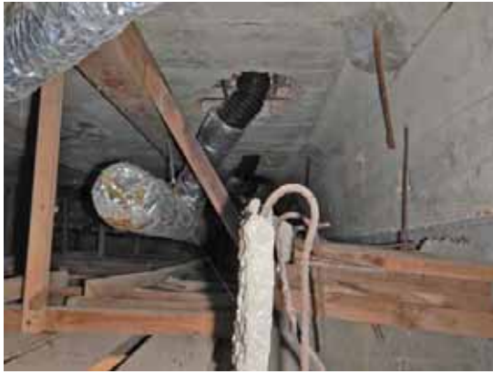
庁舎1階トイレ上部から見る躯体構造
