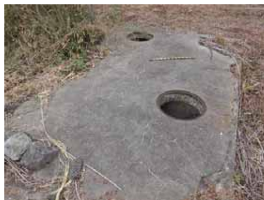
通信講堂便所 西側基礎部分 直径 50cm の穴が 2 つ開いている。
