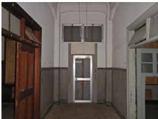
庁舎 2 階中央廊下 西側壁面
