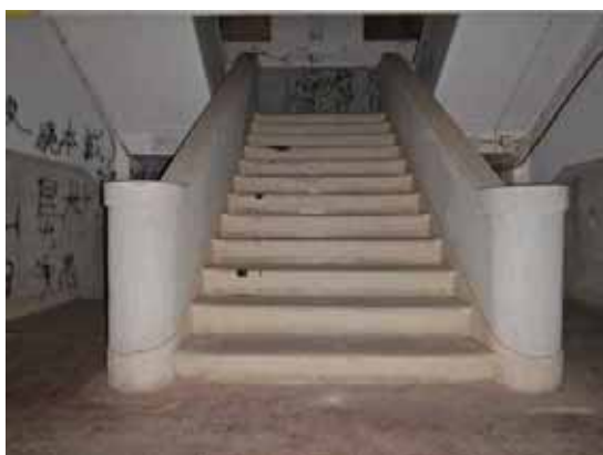
庁舎1階正面の階段
