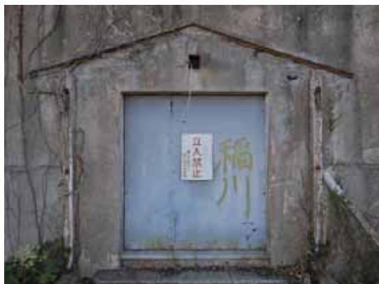
庁舎北面 士官宿舎に通じる出入口
