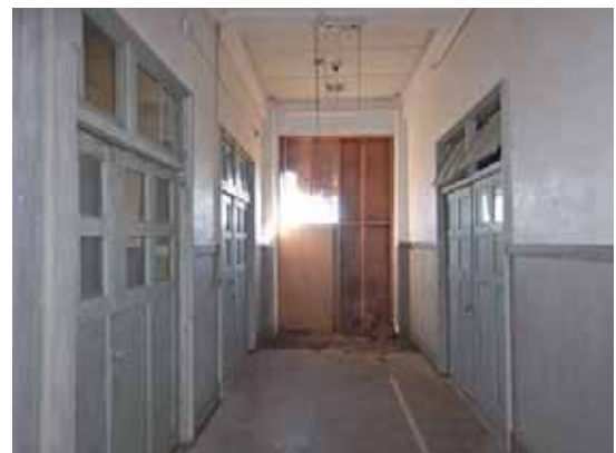
庁舎 2 階中央廊下 東側壁面
