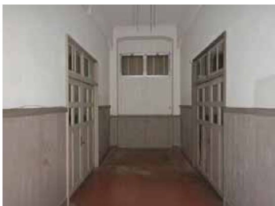
庁舎1階中央廊下 西側壁面
