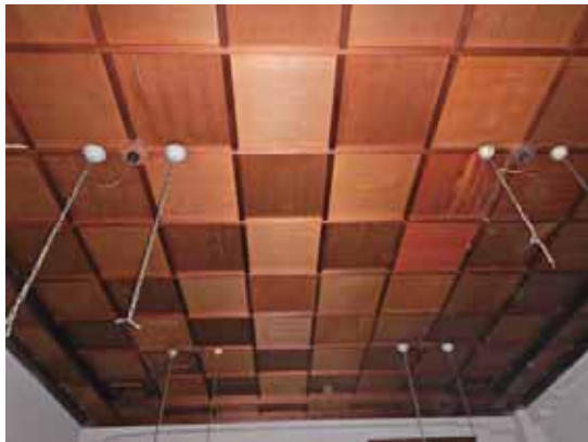
庁舎 2 階 (B11) 天井部の様子
