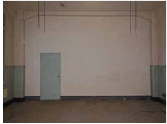
庁舎 2 階 (B16) 西側のコンクリート壁と防火戸
