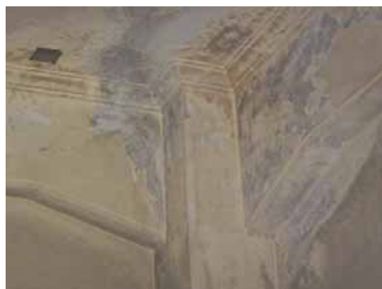
庁舎1階(A17)の天井構造の様子
