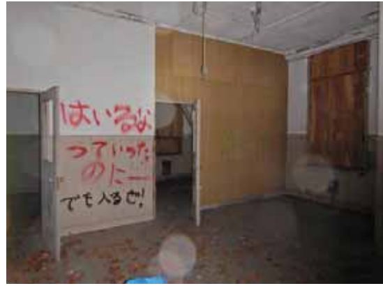
庁舎3階 (C1) C3 間の壁が合板
