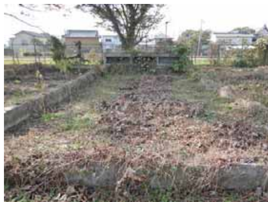
士官宿舎（第1病棟）基礎西面 西面にコンクリート製の構造物と接している
