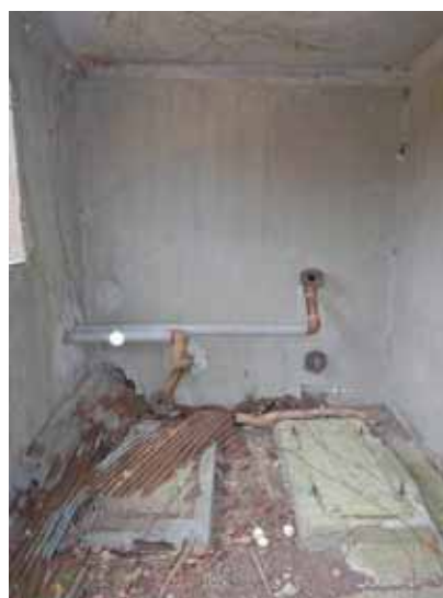
不明建築物内部の様子
