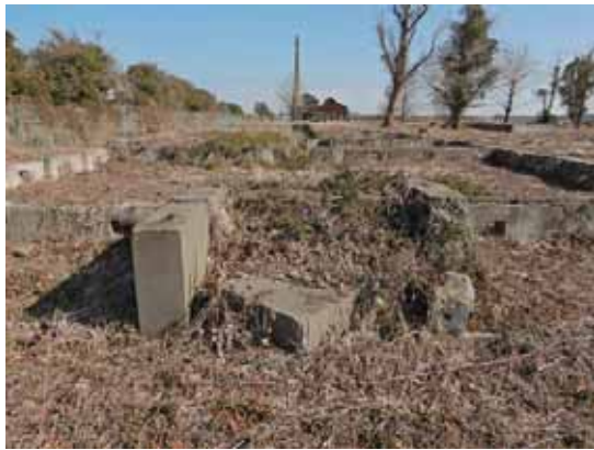
学生舎基礎 西側から
