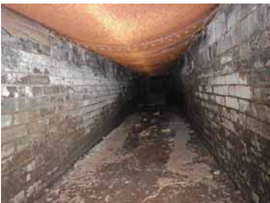
東側ランカシャーボイラー下部の様子
