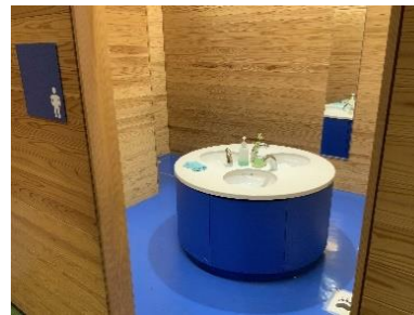
トイレ洗面台
