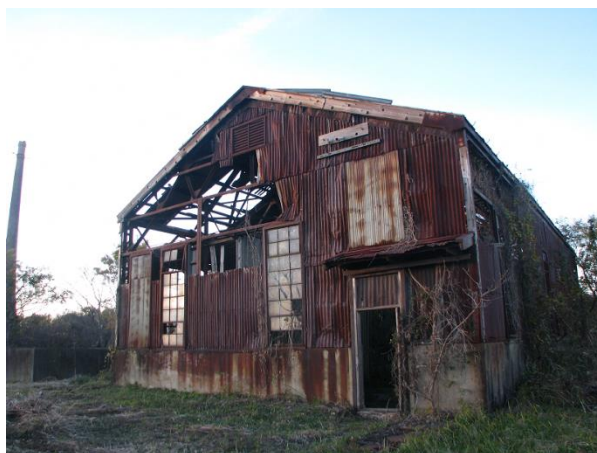
発電機棟全景
