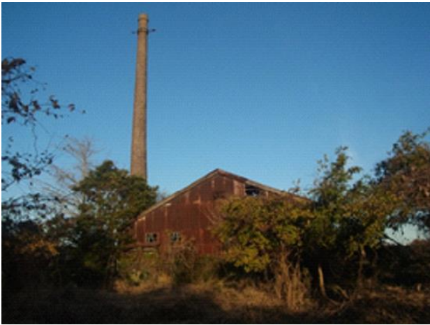
ボイラー棟全景
