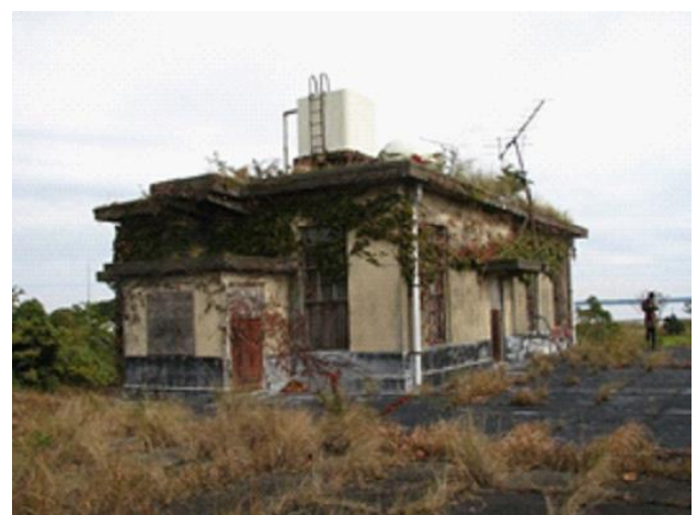
3階の塔屋（主に監視用）
