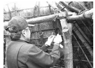
▲内側で受け取った縄を木に結びます。声をかけあい息を合わせるのがポイント！
