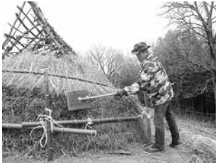
▲トントン。カヤを揃えたり隙間なく積んでいく大事な作業。
