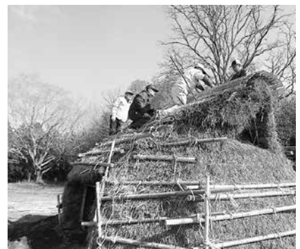
▲竹を足場にして高い位置での作業。屋根を形作っています。
