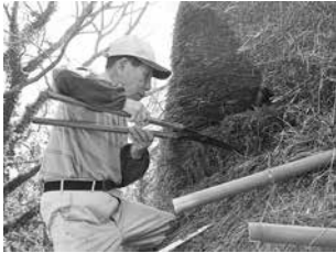
▲煙出し部分をハサミで切りそろえます。この微妙な角度が重要なんだよ。
