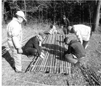
▲竹を割って縄で連結。これは屋根にかぶせます。
