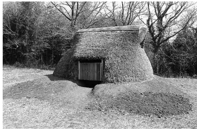
▲完成した竪穴住居
