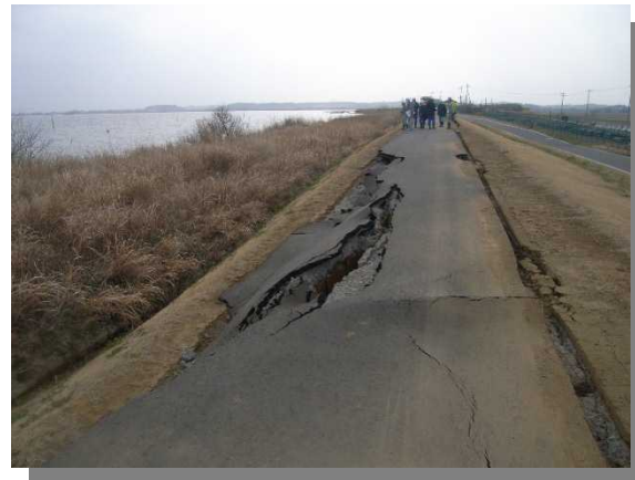
東北太平洋沖地震による被害(余郷入堤防)
