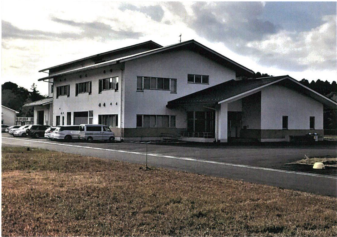
経済建設部上下水道課庁舎
