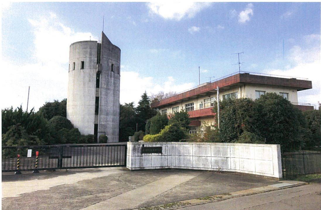
美浦村配水場
