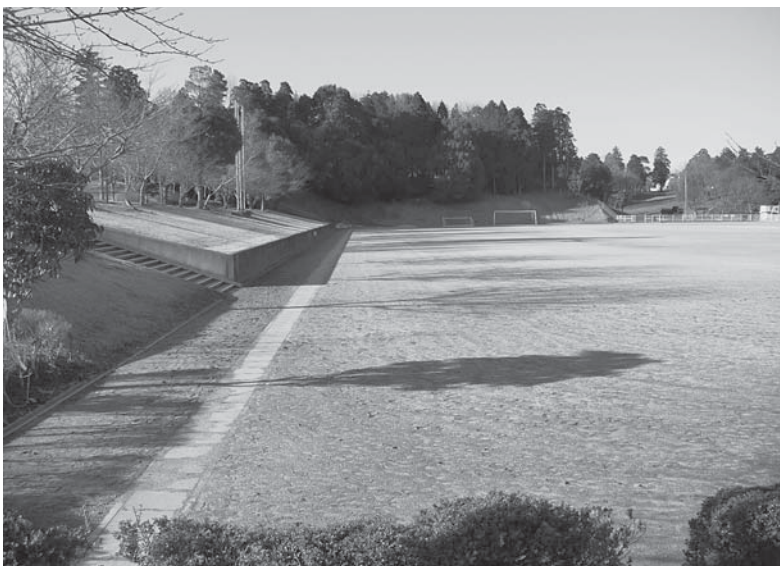
改修が望まれる多目的競技場
