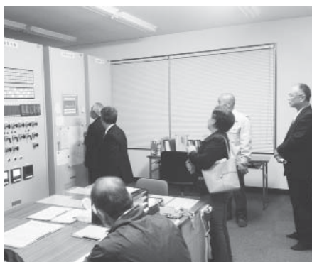
上水道設備の現場確認
