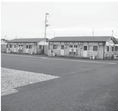
双葉町仮設住宅
