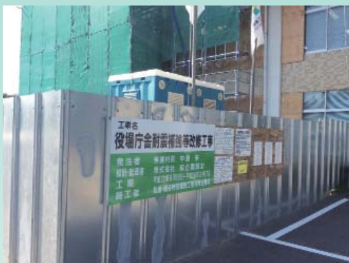
耐震工事が進められている役場庁舎
