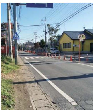
工事中の県道稲敷阿見線
