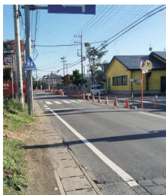
工事中の県道稲敷阿見線
