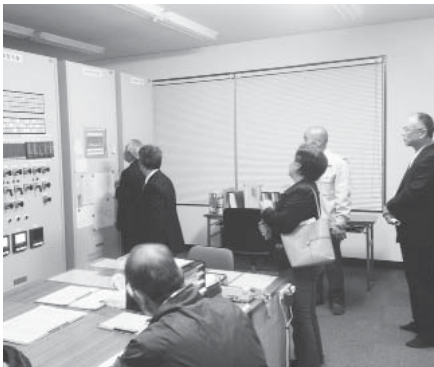
上水道設備の現場確認
