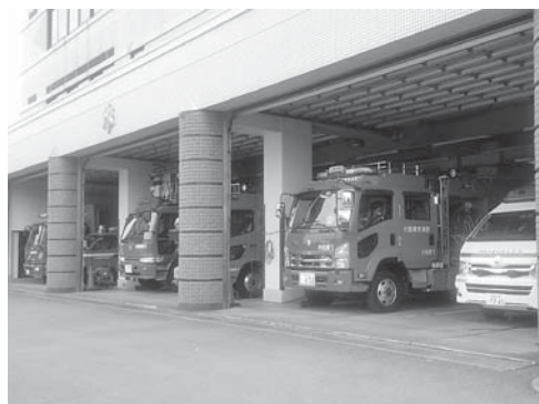
小田原市消防本部の消防設備
