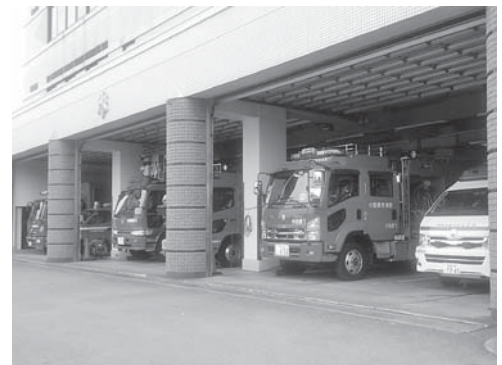
小田原市消防本部の消防設備
