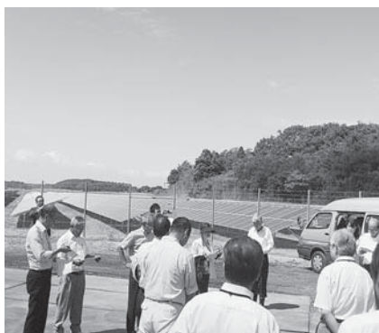
メガソーラー発電施設完成
