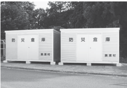
光と風の丘公園駐輪場防災倉庫
