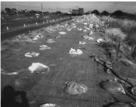
被災した霞ヶ浦護岸堤防
