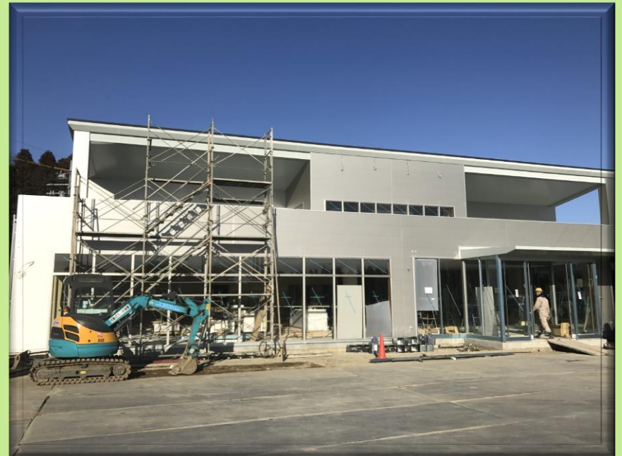
工事進捗状況
