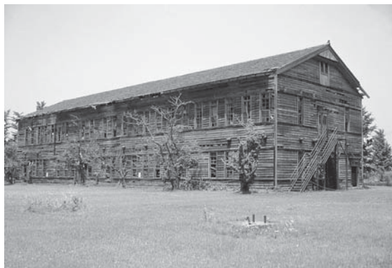
▲鹿島海軍航空隊施設②—木造兵舎— 旧司令官本館裏にあり、当時、海軍士官が寝泊まりしていました。平成10年（1998）老朽化のため解体撤去されました。
